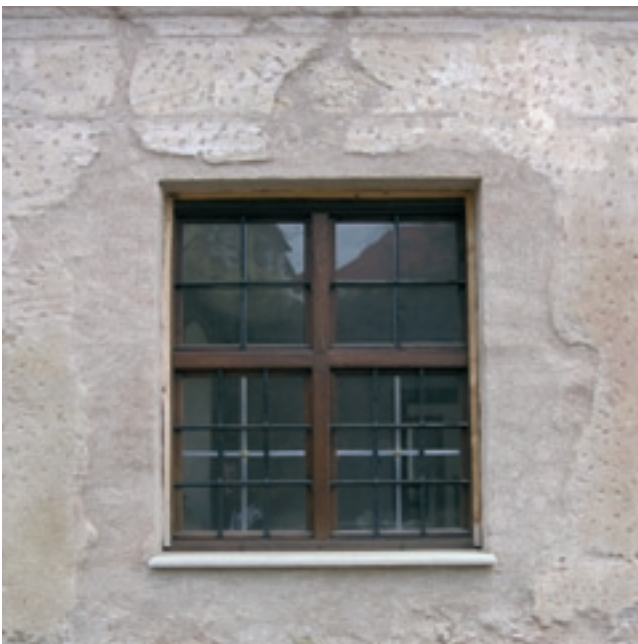
Fenster, Fassadenputz; historischer Bestand bleibt erhalten
