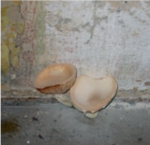
Mauerwerk, Pilzbefall Bürgerhaus in Augsburg, Wandmalerei
