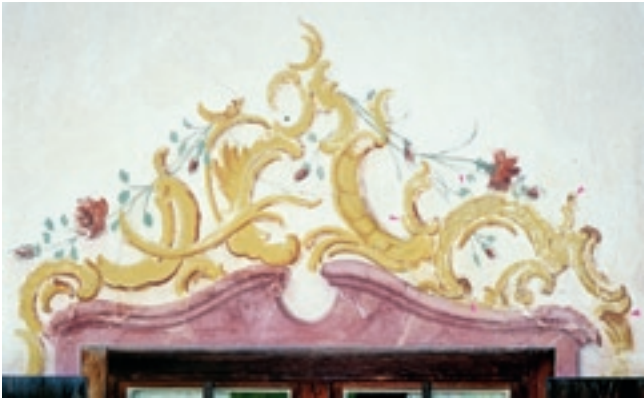
Bauernhaus; Rokokomalerei vor der Restaurierung
