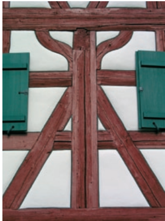
Fachwerkfassade, Reparatur und Wiederherstellung der historischen Farbgebung
