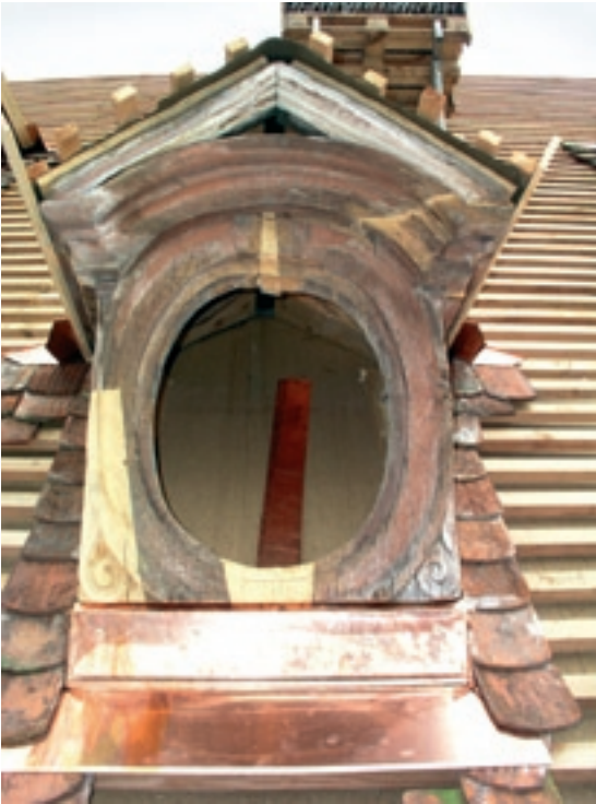
Barocke Dachgaube nach der Reparatur
