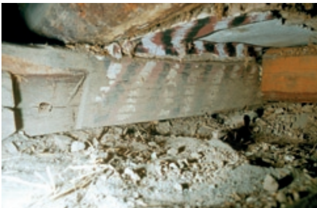
Blick in einen Fehlboden; baugeschichtliche Spurensicherung
