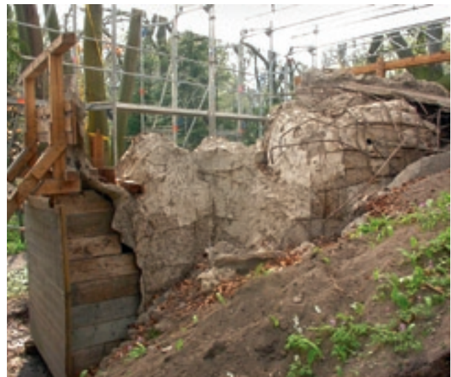
Künstliche Jurahöhle in Erlangen; Ergänzung der historischen Mörtelschale
