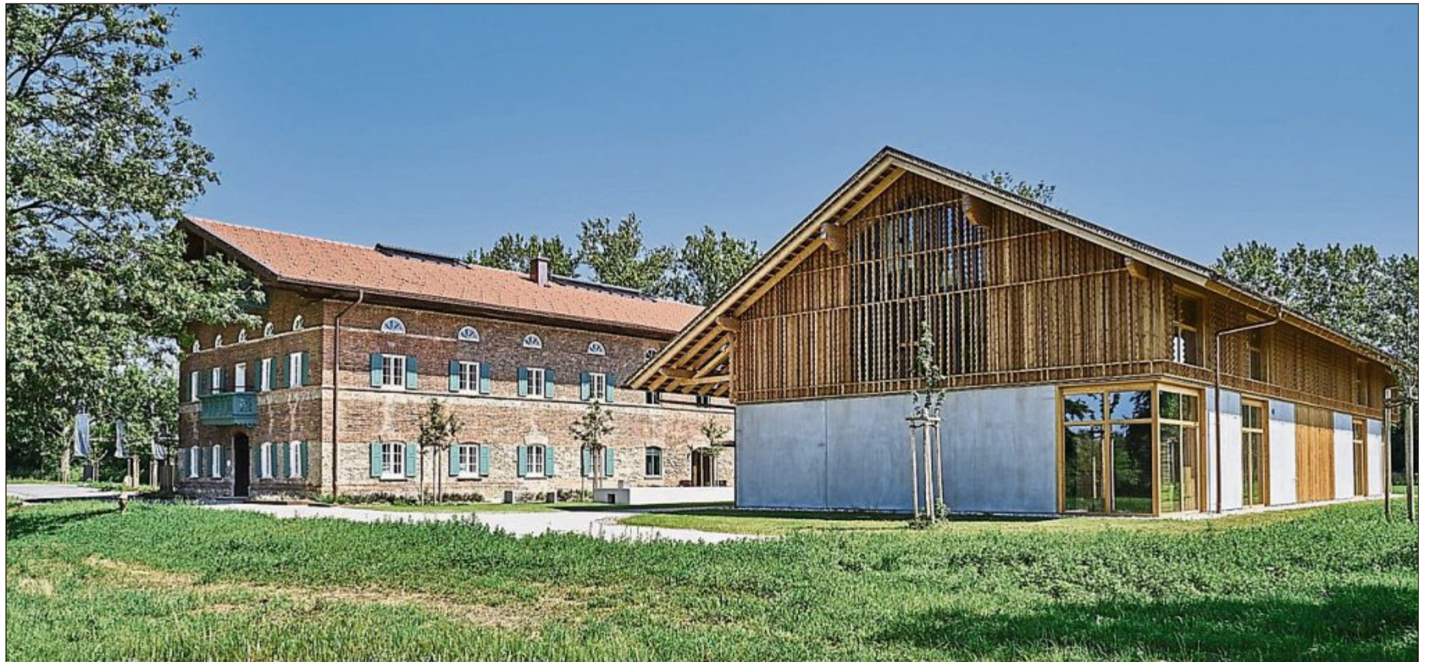
Instandsetzung eines Bauernhauses und Ersatzbau für die Scheune in Rosenheim: kammerl+kollegen architekten. Das Objekt war Teil der Architektortour 2019 im Bereich „Beispielhafte Bauten“. FOTO: JULIA HILDEGARD, INGOLF HATZ
