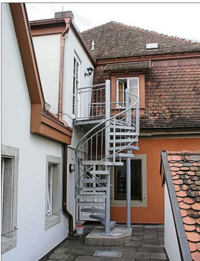
Zur Sicherstellung der Flucht- und Rettungswege sind häufig außen liegende Treppen oder auch Stege nötig. Auch bei beengten örtlichen Verhältnissen lassen sich Flucht- und Rettungswege verwirklichen.
