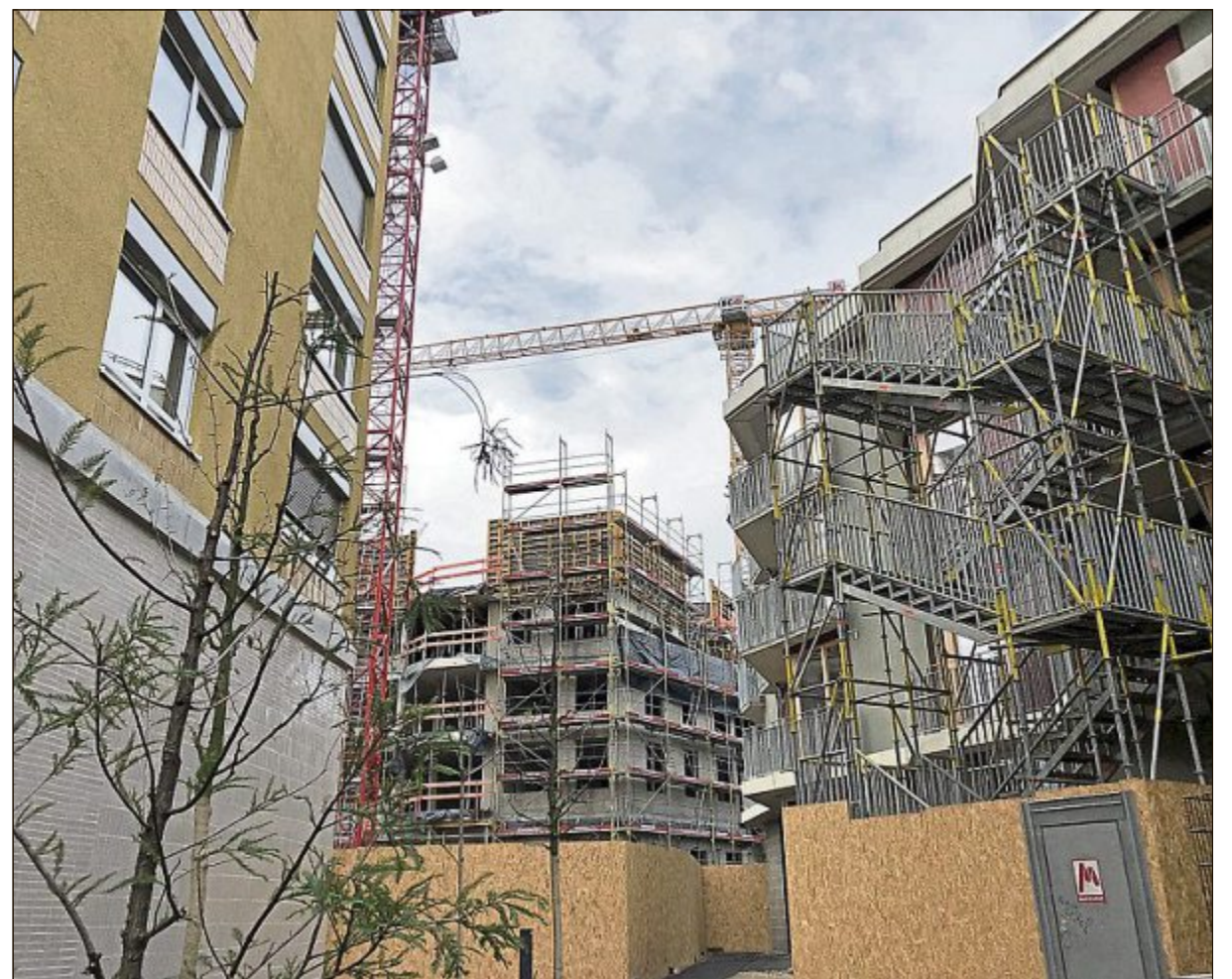
Baustelle des BayernHeim-Wohnprojekts in der Münchner Hansastraße.
